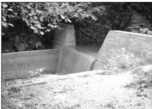
Lucrari hidrotehnice de amenajare si corectare de torrenti executate in raza Ocolului Silvic Mehadia
